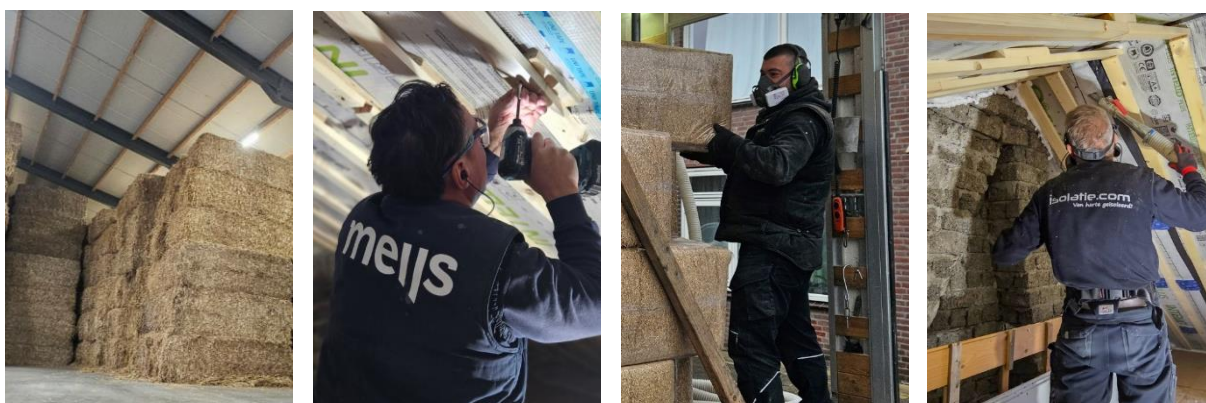
Bio-gebaseerde dakisolatie. Een proces van samenwerking tussen verschillende partijen.
