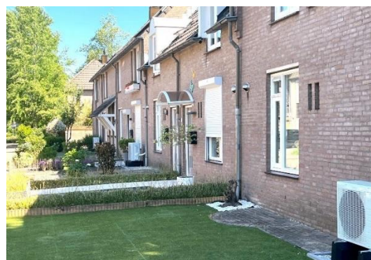
Rijwoning aan de Schoor in Gemert. Pilot binnen het project van het hybridiseren.
