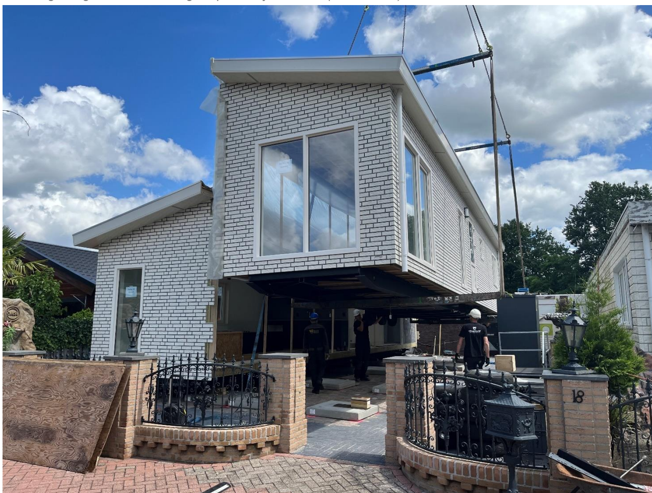
Plaatsing energieneutrale huurwagen op De Peij in Gemert (28 mei 2024).
