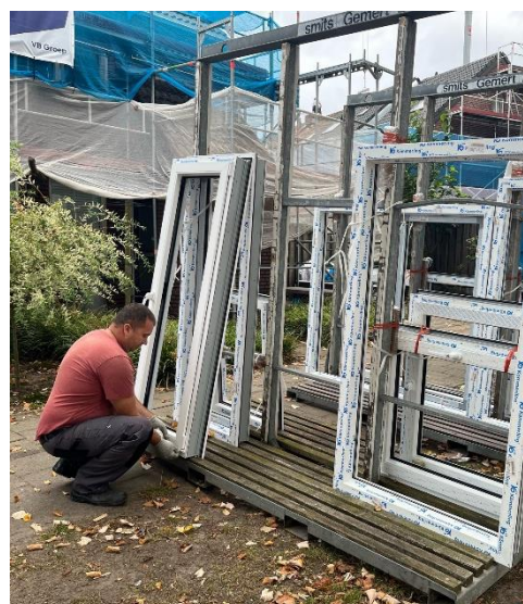
Vervangen kozijnen woningen Heijtsveld (Gemert) tijdens groot onderhoud.
