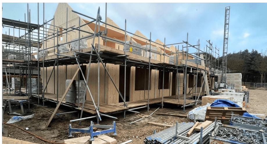
5 woningen Roessel (Bakel) duurzame houtbouw (BOTS bouwgroep).
